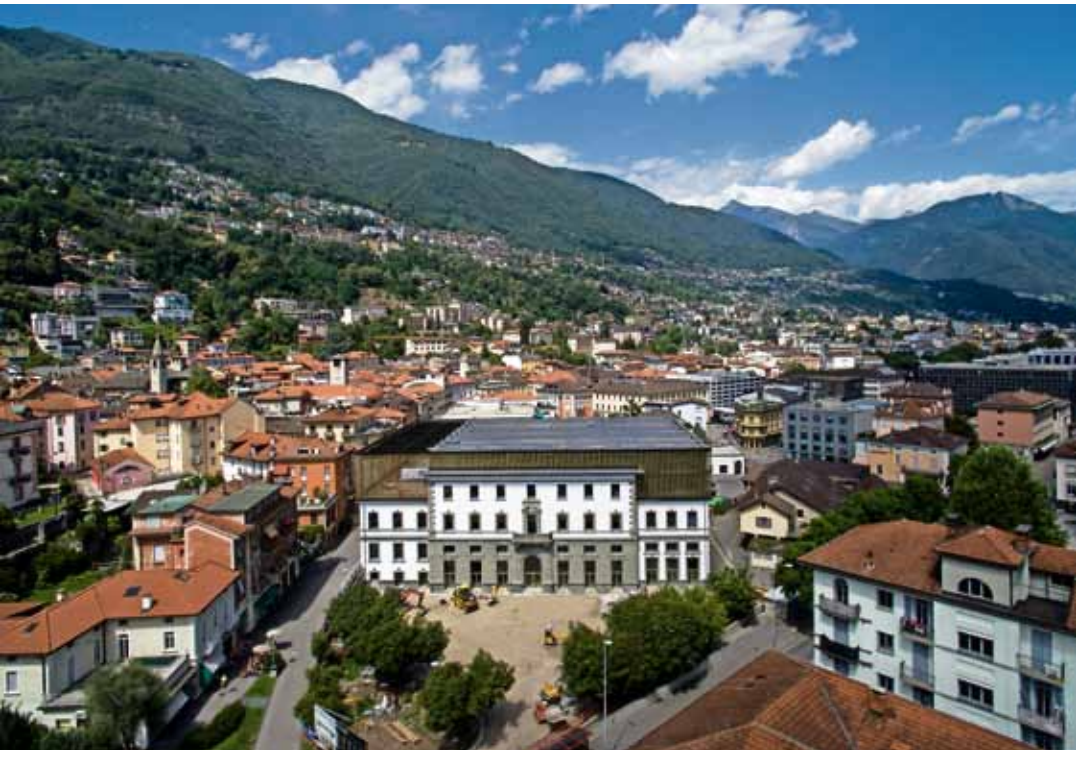
Il Palazzo del Cinema di Locarno: della vecchia scuola è rimasta solo la muratura perimetrale. (Ti-Press)
