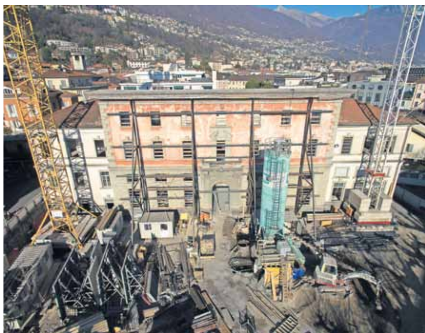
La vecchia sede delle scuole comunali durante il cantiere. (Ti-Press)
