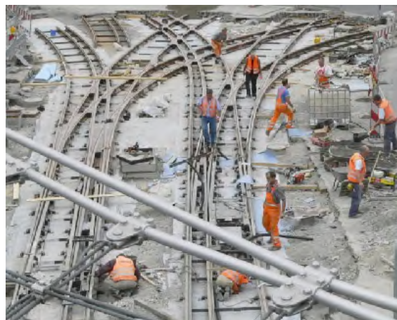
Figura 26: Scambi a due scartamenti in costruzione presso la Löwentor a Monaco (D)
